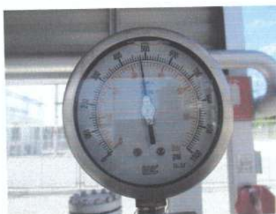
รูปมาตรวัดแรงดันก่อนเข้าอุปกรณ์ปรับลดแรงดัน
